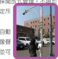
師生們只要在校園內遭遇緊急事件時，就近到求救亭按下緊急求助鈕，會自動送出異常警報聲響，立即與警衛室、校安中心聯絡，除了錄存事件發生時的影像聲音，以利日後調閱，還可顯示相關位置圖、求救對話，警衛室及時派員處理；並可透過管理系統設定，啓動語音系統或簡訊系統，使每一異常事件都在系統的管控下，迅速處理降低傷害，節省校方維護安全人力支出的有效管理。
